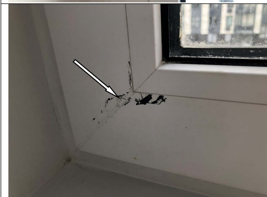
Фото №48. Загрязнения на профиле оконного блока ПВХ в кухне в квартире.
