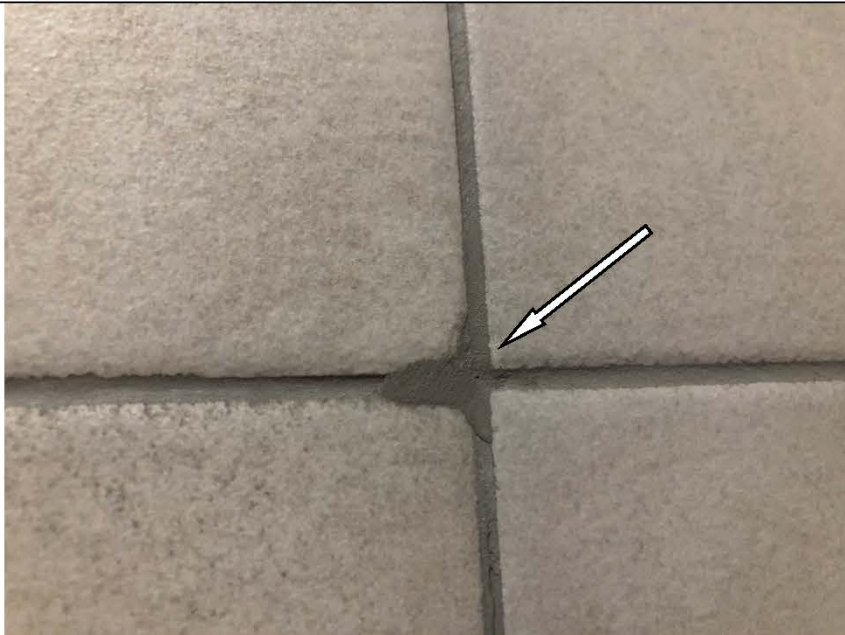
Фото №55. Загрязнения на напольной керамической плитке в ванной комнате в квартире.
