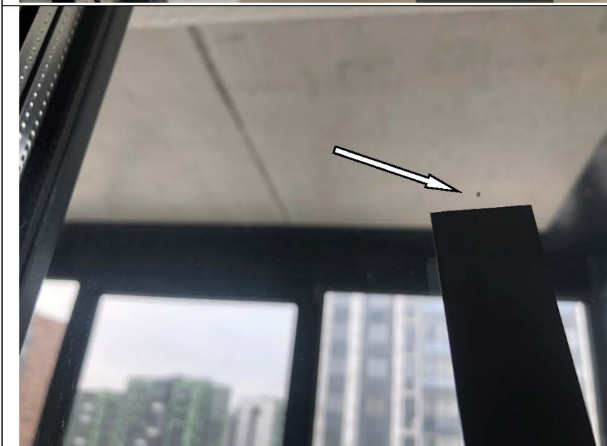
Фото №44. Окарины на стеклопакете оконного блока ПВХ в спальне в квартире.
