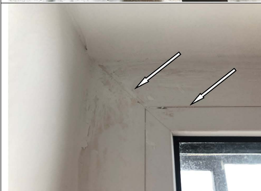
Фото №47. Загрязнения на профиле и инфильтрация оконного блока ПВХ в спальне в квартире.
