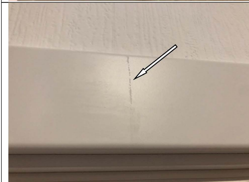
Фото №18. Загрязнения на наличнике деревянного дверного блока в ванной комнате в квартире.
