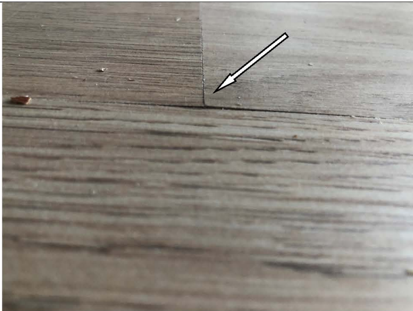
Фото №50. Поднятые кромки досок ламината в спальне в квартире.
