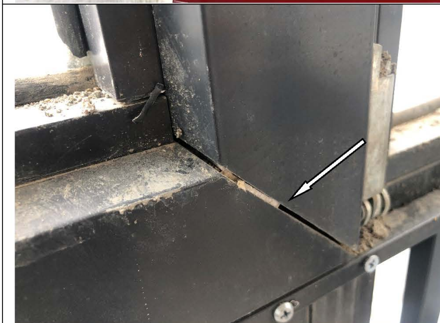
Фото №53. Дефект на металлическом профиле оконного блока на лоджии в квартире.
