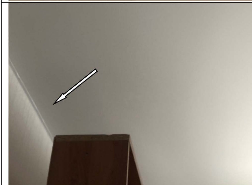
Фото №20. Загрязнения на полотне натяжного потолка в спальне в квартире.
