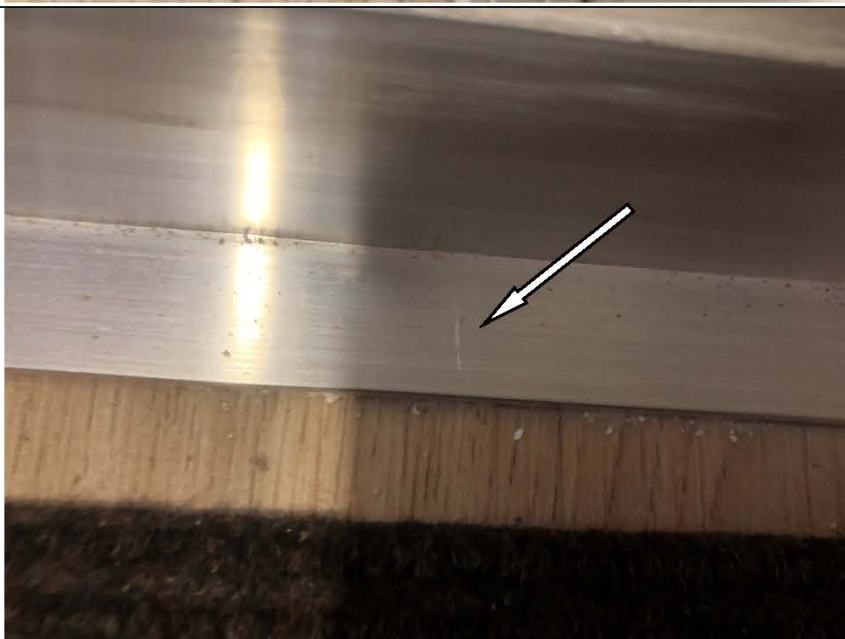
Фото №60. Царапина на напольном металлическом порошке в коридоре в квартире.
