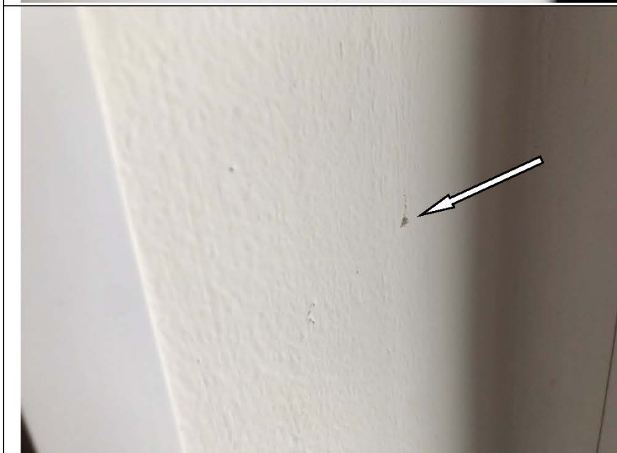
Фото №41. Неровности, сколы на окрашенных откосах оконного блока ПВХ в спальне в квартире.
