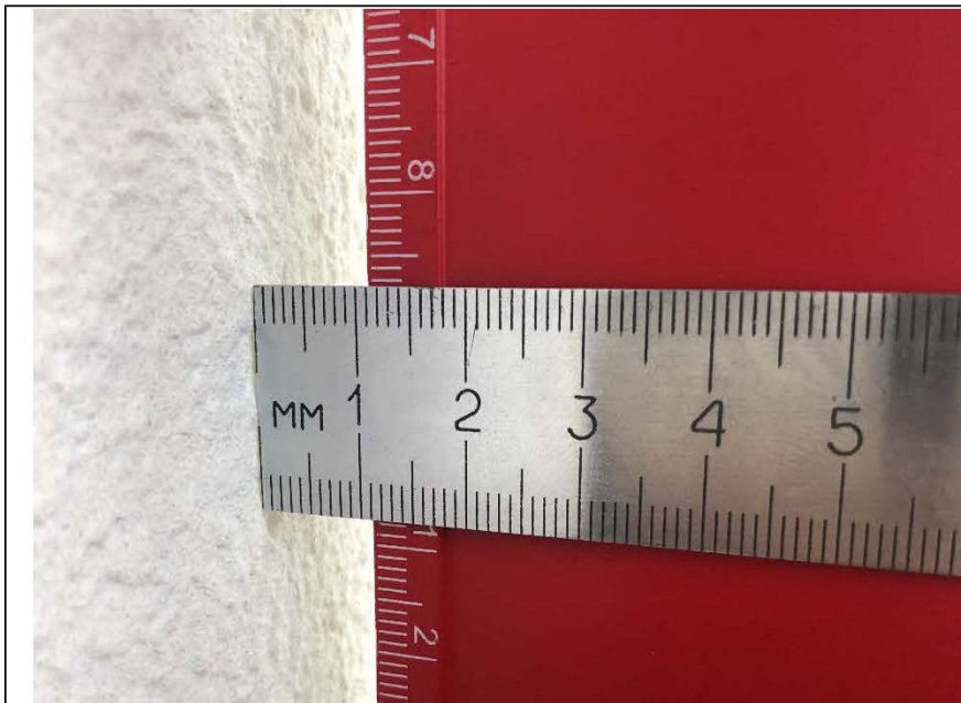
Фото №52. Измерение уровня стен на лоджии в квартире.
