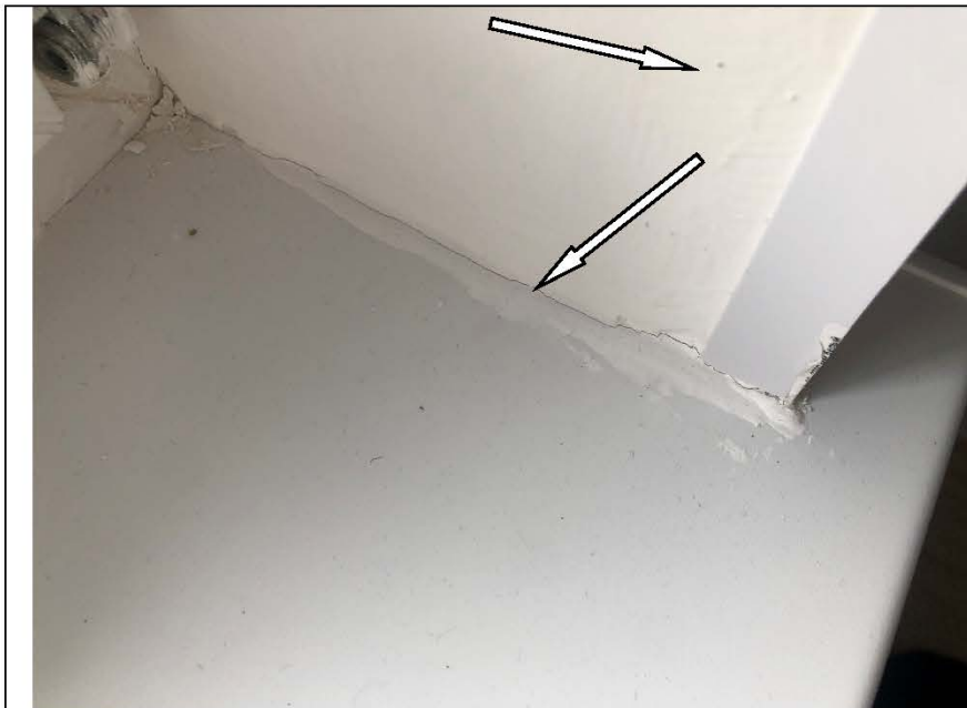
Фото №40. Загрязнения на подоконной доске и сколы, неровности на окрашенных откосах оконного блока ПВХ в кухне в квартире.
