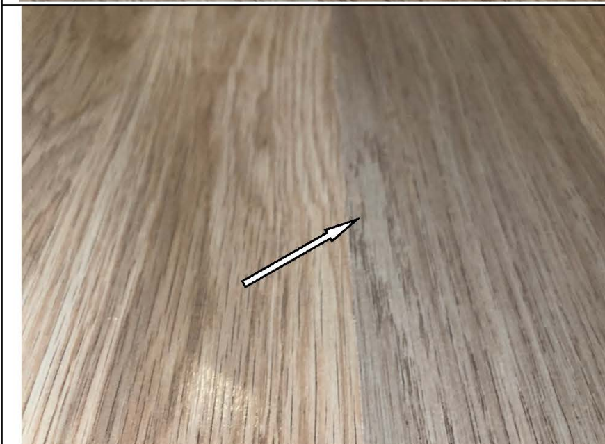
Фото №27. Шероховатости на поверхности ламината в спальне в квартире.
