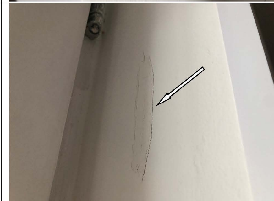
Фото №42. Неровности, сколы на окрашенных откосах оконного блока ПВХ в спальне в квартире.
