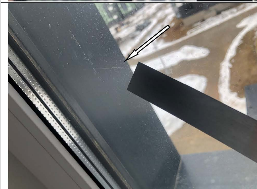
Фото №45. Царапины на стеклопакете оконного блока ПВХ в кухне в квартире.
