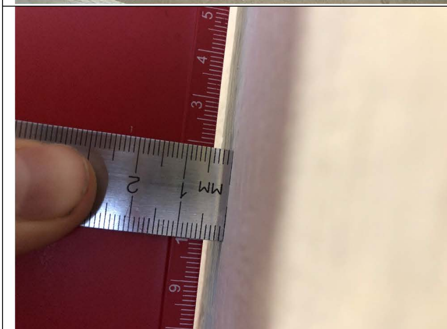
Фото №6. Измерение уровня стен коридора в квартире.
