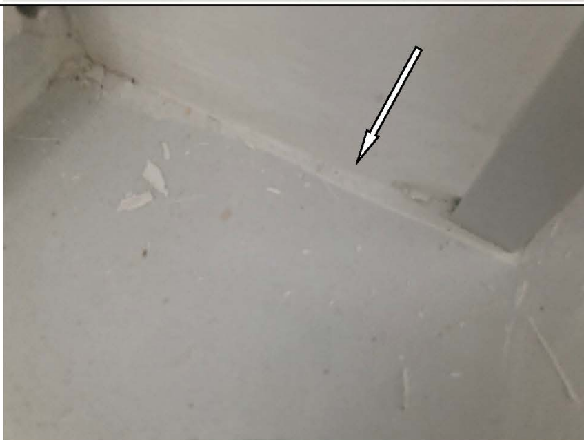
Фото №39. Загрязнения на подоконной доске в спальне в квартире.
