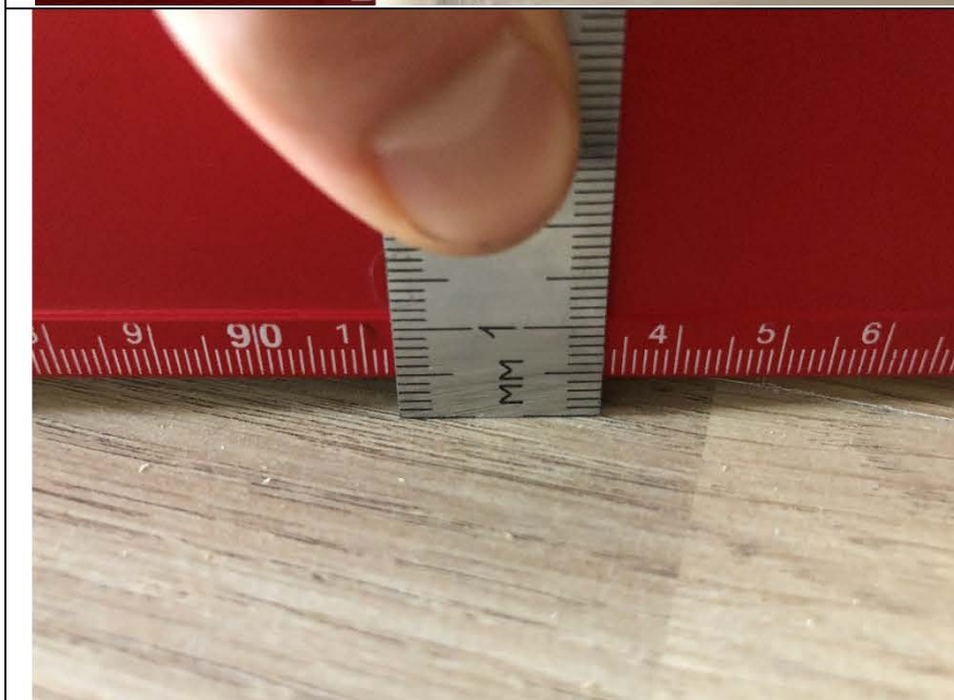
Фото №9. Измерение напольного покрытия коридора в квартире.
