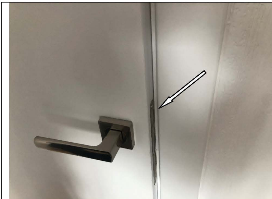
Фото №31. Свободно не закрывается дверь в спальне в квартире.
