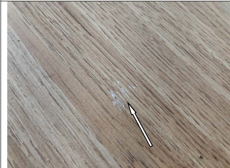
Фото №26. Загрязнения на поверхности ламината в спальне в квартире.
