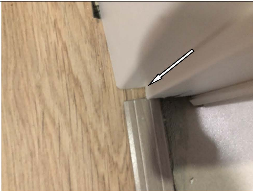
Фото №59. Частично не хватает напольного металлического порошка в ванной комнате в квартире.
