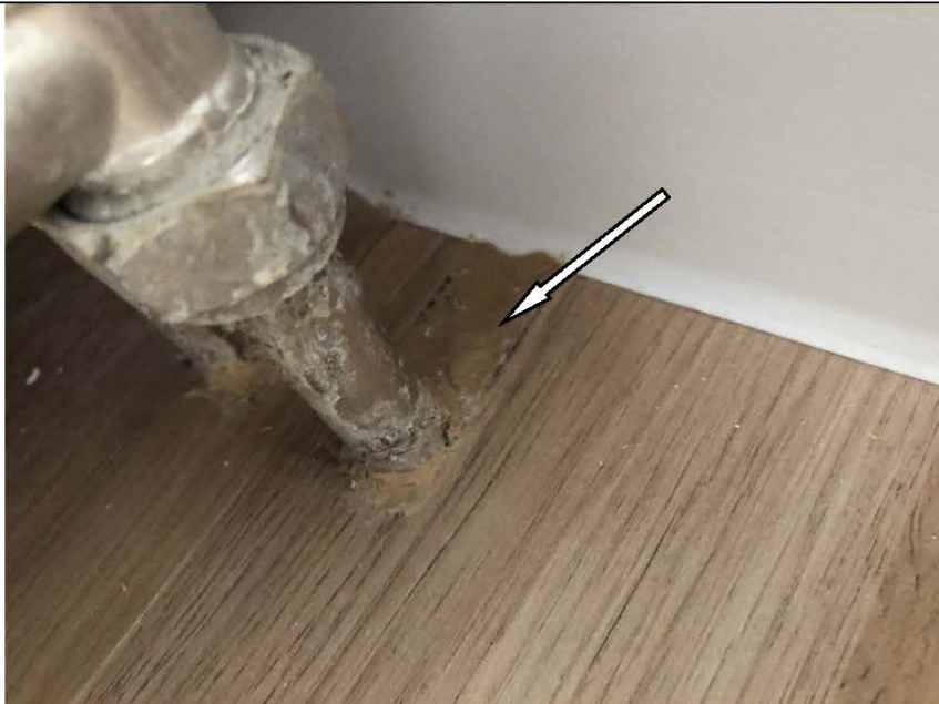
Фото №34. Дефект вставки труб отопления в напольное покрытие из ламината в спальне в квартире.
