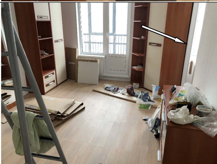
Фото №3. Общий вид спальни в квартире. Отсутствует кухонная дверь (полотно, коробка, наличники)
