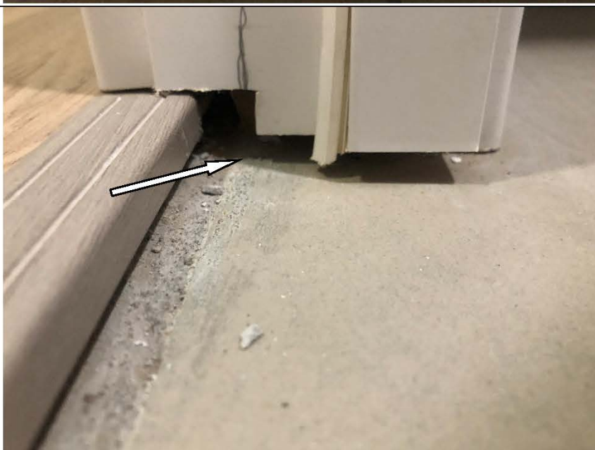
Фото №57. Наличник деревянного дверного блока не достает до напольного покрытия в ванной комнате в квартире.
