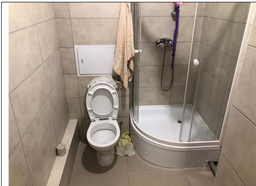
Фото №4. Общий вид ванной комнаты в квартире. Отсутствует полотенцесушитель.
