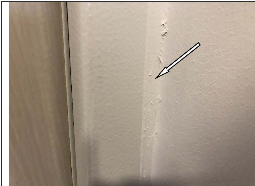
Фото №13. Загрязнения на коробке комбинированного дверного блока в коридоре в квартире.
