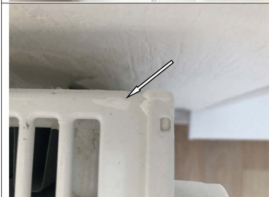
Фото №32. Загрязнения на кожухе отопительного прибора в спальне в квартире.
