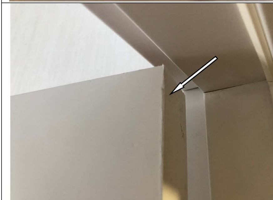
Фото №15. Скол на полотне деревянного дверного блока в спальне в квартире.
