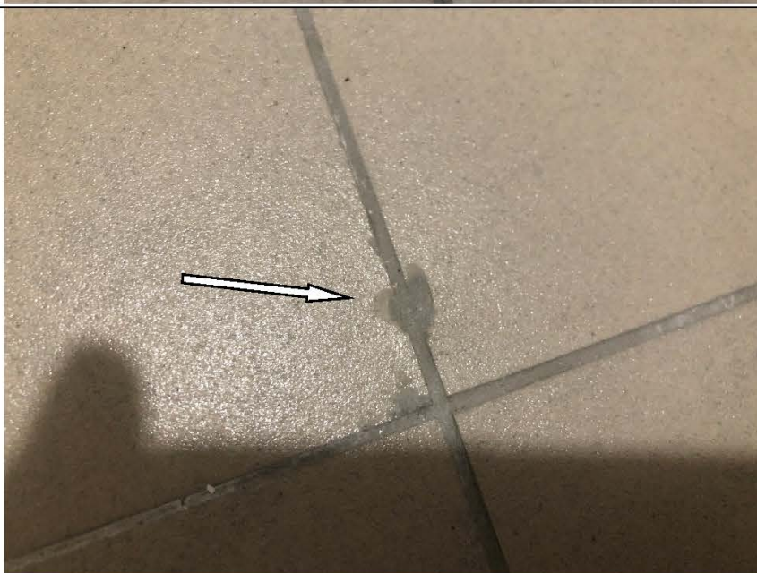
Фото №56. Скол на напольной керамической плитке в ванной комнате в квартире.
