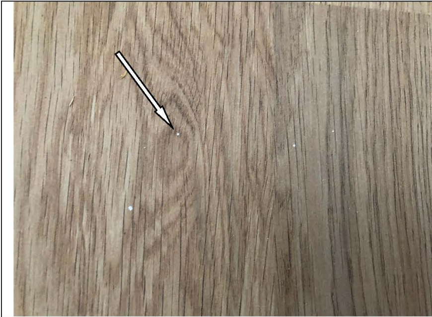
Фото №25. Загрязнения на поверхности ламината в кухне в квартире.
