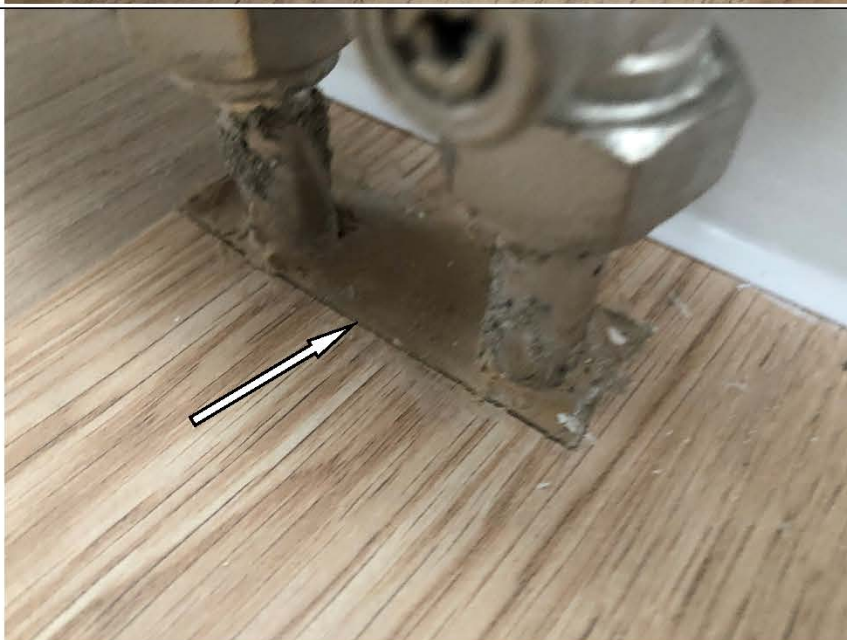
Фото №35. Дефект вставки труб отопления в напольное покрытие из ламината в кухне в квартире.
