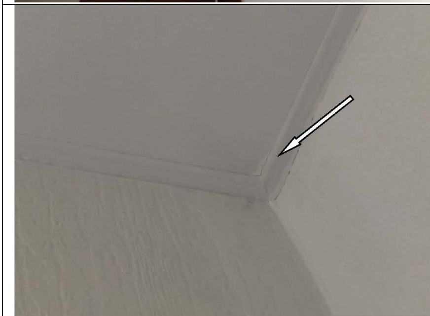
Фото №21. Загрязнения на полотне натяжного потолка в кухне в квартире.
