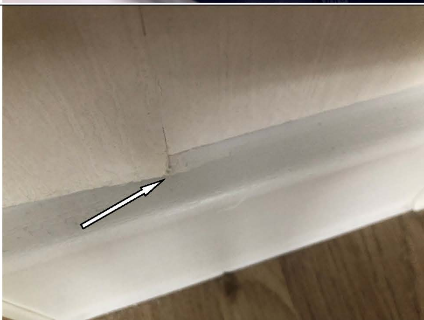
Фото №29. Загрязнения на напольном плинтусе ПВХ в спальне в квартире.
