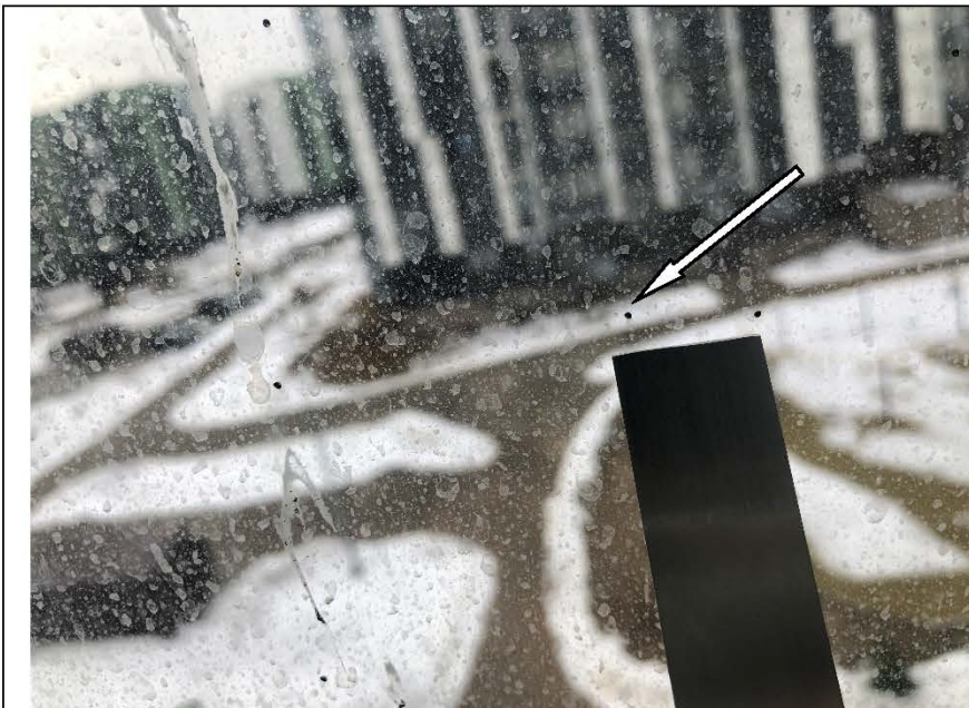
Фото №46. Окарины на стеклопакете оконного блока ПВХ на лоджии в квартире.
