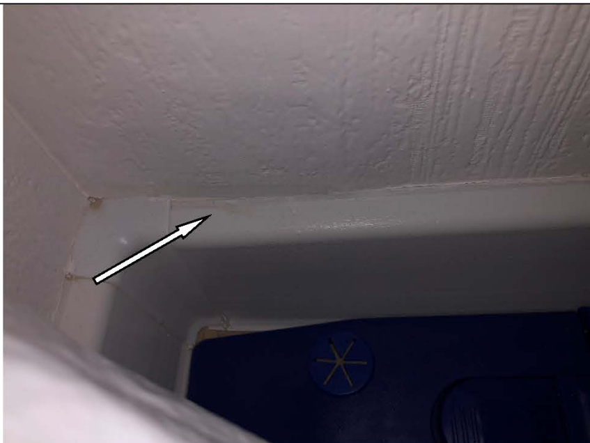
Фото №28. Загрязнения на напольном плинтусе ПВХ в коридоре в квартире.
