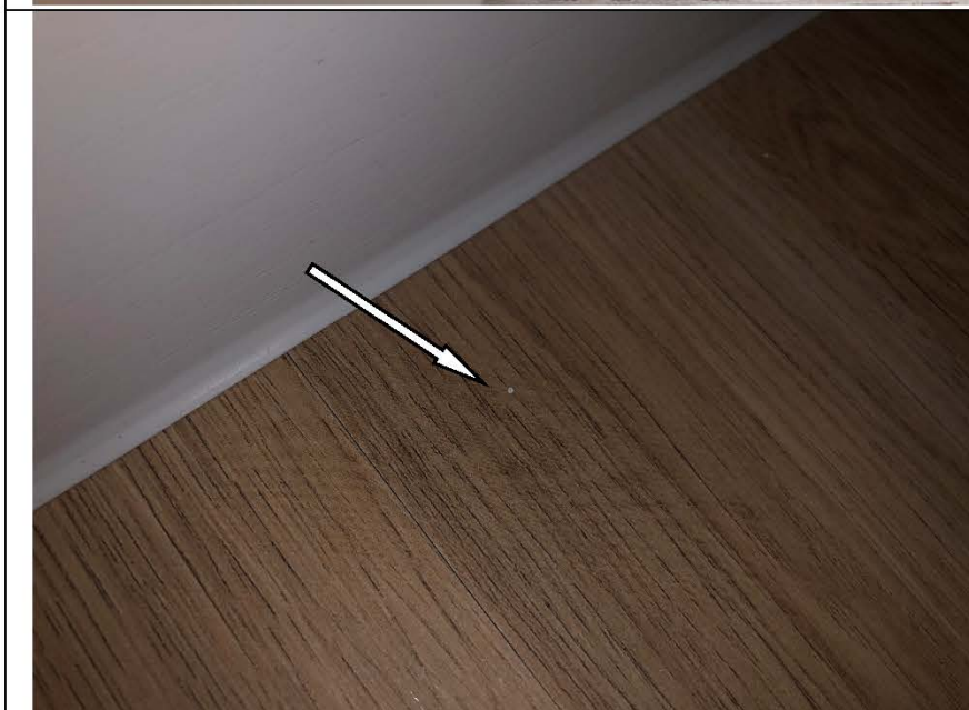
Фото №24. Загрязнения на поверхности ламината в коридоре в квартире.
